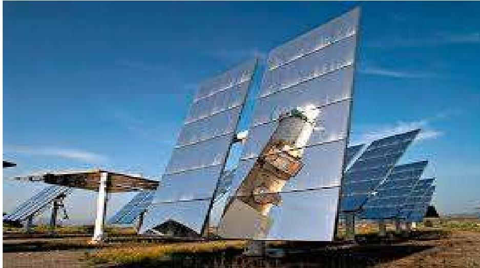
**Los espejos solares siguen la trayectoria del sol y concentran el calor en una torre provista de un líquido especial que trepa a 500 °C. Con esto se genera vapor de alta entalpia y luego se produce electricidad, en turbinas**
