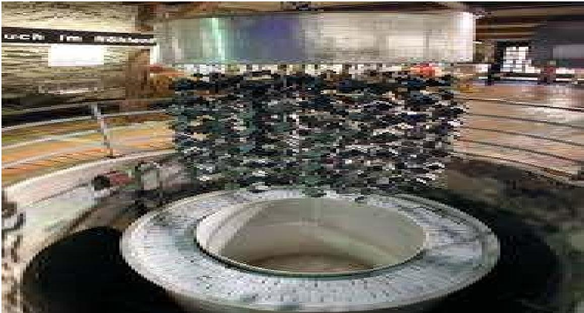
**Planta interior donde se produce la fisión nuclear. En caso del proceso ABBCo se deberá rellenar con bolas de grafito (polvo uranio en interior) y fisionar. A continuación, pasar gas helio**
